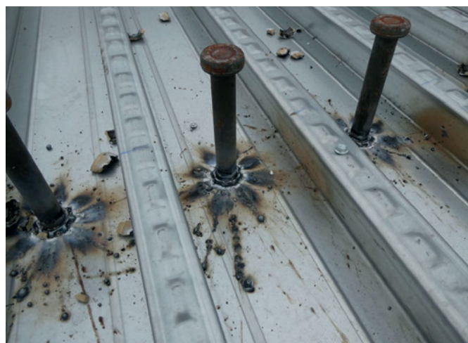
▲ Bild 13. Durchgeschweißte Bolzen ohne Beanstandung (Bilder: SLV München (4, 5), Trillmich)
