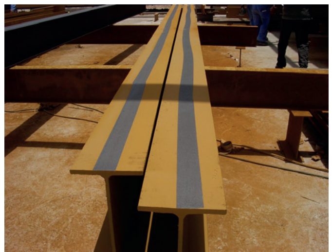
▲ Bild 7. Der abgeklebte Bereich bleibt unbeschichtet.
