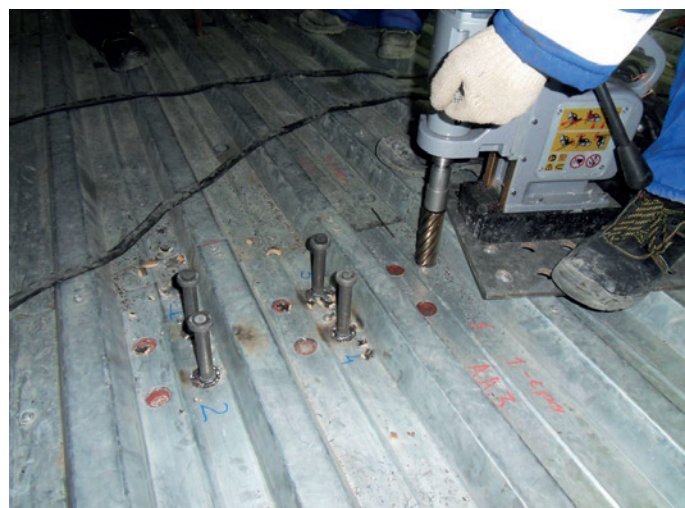
◀ Bild 10. Ausbohren des Blechs zum direkten Schweißen auf den Träger
