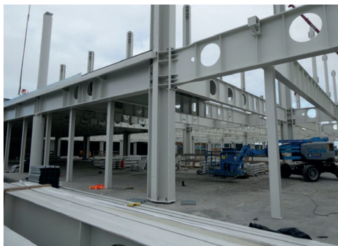
▲ Bild 12. Günstige Gestaltung des Knotenbereichs zur Aufnahme seismischer Beanspruchung
