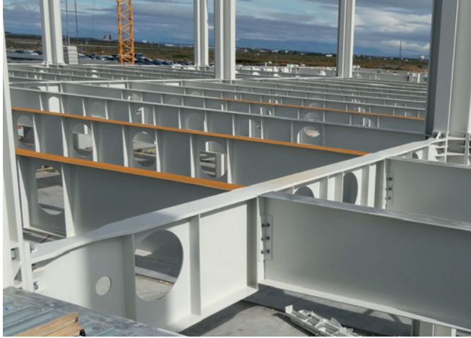
▲ Bild 8. Die Beschichtung auf dem Obergurt muss entfernt werden, leichter Rost ist unbedenklich.
